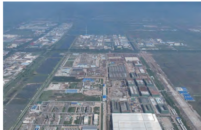
近日，江苏凯实金桥公司年产 16.8 万吨新能源电池关键材料及关联产品项目现场一片繁忙。作为聚焦新能源电池正极材料核心供应的关键项目，其加速建设将精准补齐产业链关键环节，为当地新能源产业升级注入强劲动力。（刘 佳）
